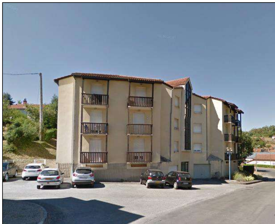
Figure 44 : Logement de tourisme à Cransac, source : Google Street
