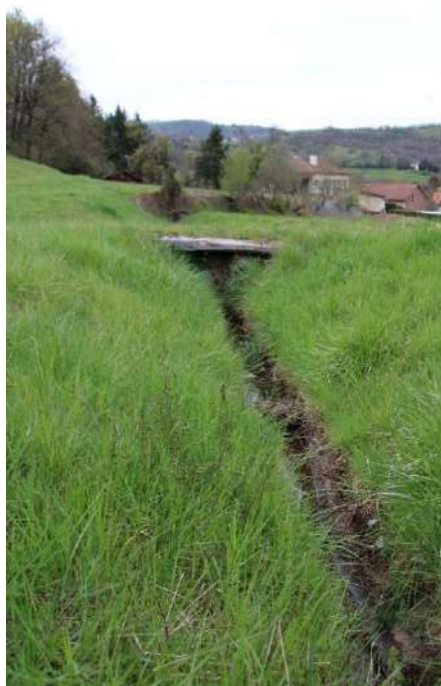
Drain et passage pour piéton Source : Artifex 2019
